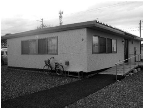
千厩仮設住宅団地 集会所
